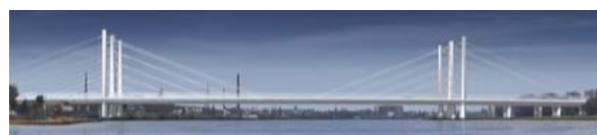
Neubau Rheinbrücke Duisburg
